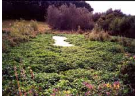
6.3. att. Augu lagūnas tipa attīrīšanas dīķis pirms un pēc aizaugšanas, novietots aiz recirkulācijas sistēmas foreļu audzētavas Dānijā. Avots: Per Bovbjerg, DTU Aqua
