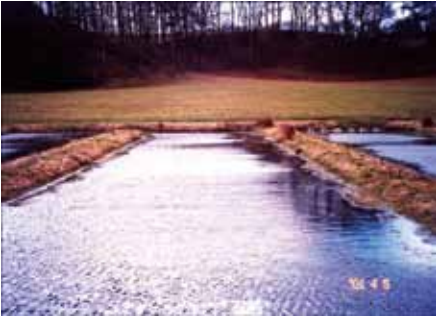
6.3. att. Augu lagūnas tipa attīrīšanas dīķis pirms un pēc aizaugšanas, novietots aiz recirkulācijas sistēmas foreļu audzētavas Dānijā. Avots: Per Bovbjerg, DTU Aqua
