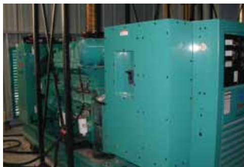
2.19. att. Skābekļa rezervuārs un rezerves elektroģenerators.
