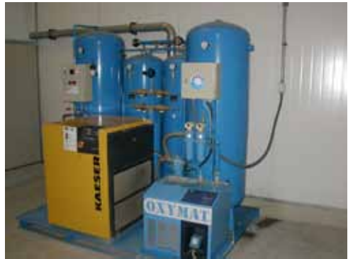
5.2. att. Skābekļa ģenerators. Jārūpējas par specializēto ierīču kontroli un apkopi
