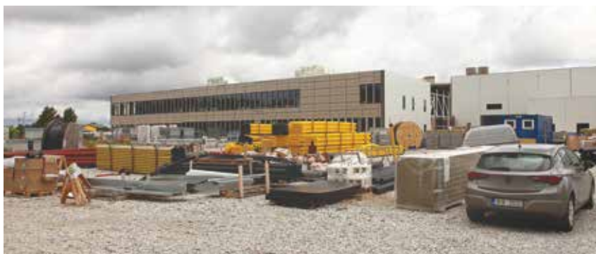
E-piim topošās piena pārstrādes rūpnīcas būvlaukumā
