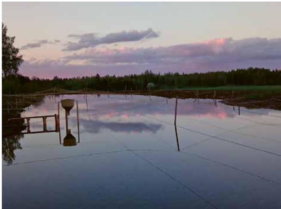
Dīķis pēc rekonstrukcijas ar uzstādītu zivju aizsargtīklu
