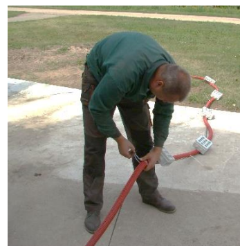
3.4. att. Sensoru montāža uz caurules.
