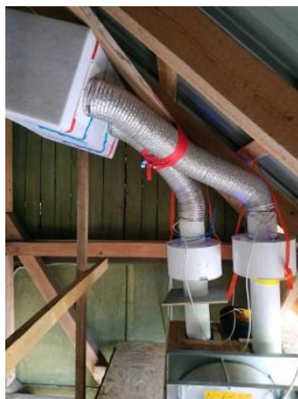
3.14. att. Gaisa filtra pieslēgums ģeneratoriem.
