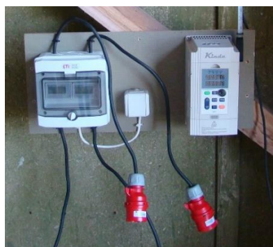
3.3. att. Skaitītāju pieslēguma vieta.
