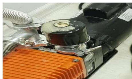
Vakuums, šķidrums tiek „ierauts” kompresorā
