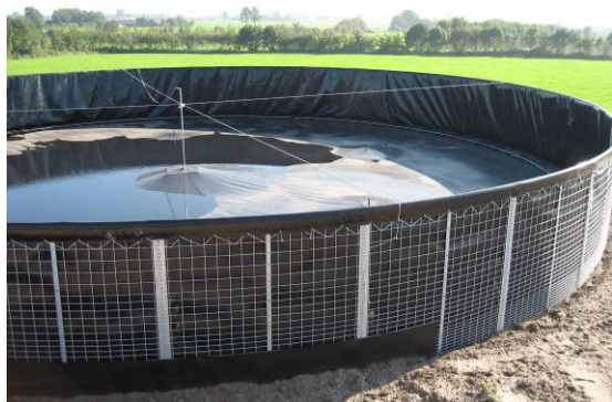
2. att. Lagūnas tipa šķidrmēsļu krātuve
