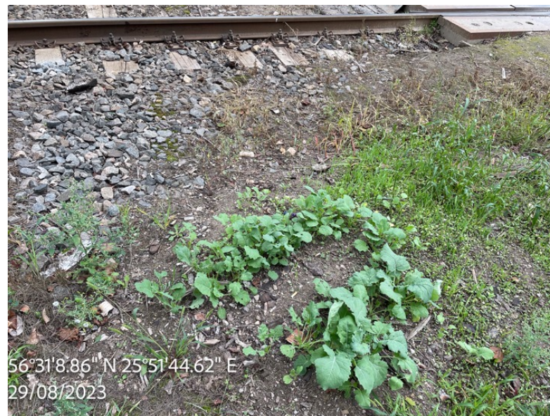
Jēkabpils, dzelzceļa pārbrauktuve Madonas ielā. Pievedceļš "Elagro Trade". 29.08.2023.
