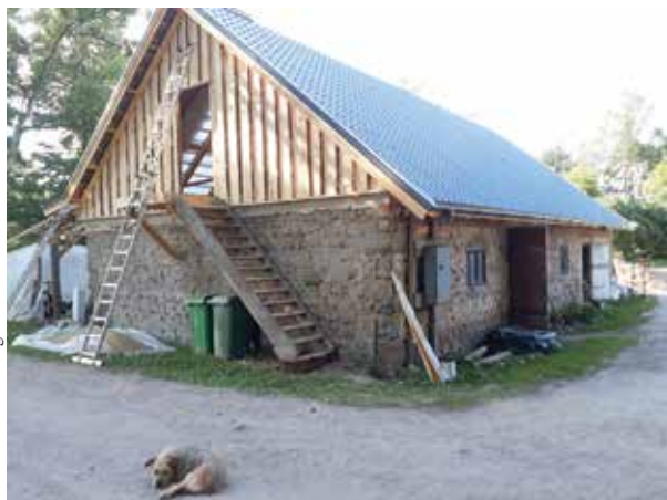
Tiek renovēta kūts
