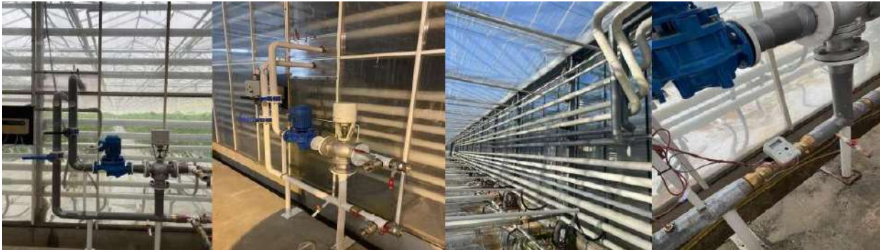
7.8. att. Eksperimentālā siltumnīcas siltummezgla un siltumtrases izbūve
