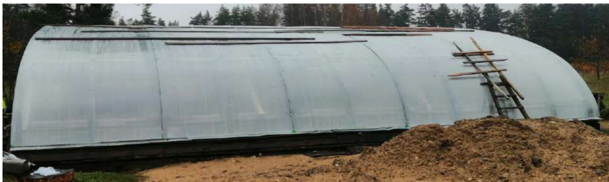
7.2.8. att. Siltumnīcas pārklājuma 6mm polikarbonāta montāža
