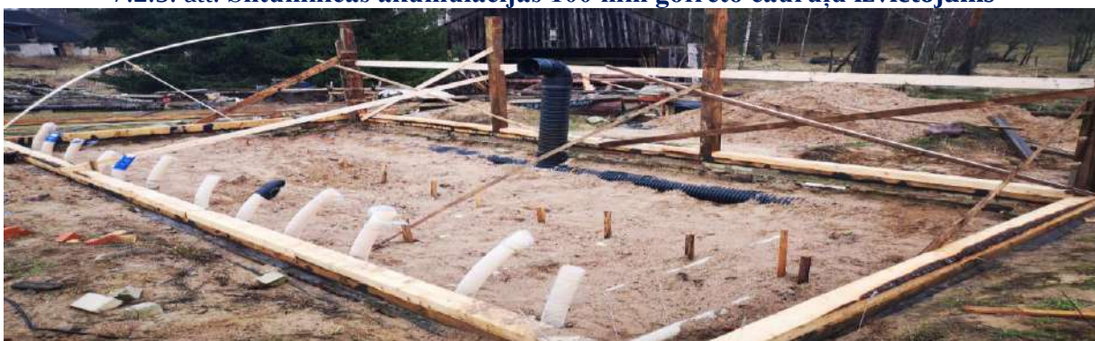
7.2.6. att. Siltumnīcas grants akumulācijas slāņa izveide
