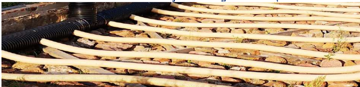
7.2.4. att. Siltumnīcas akumulācijas 100 mm gofrēto cauruļu montāža
