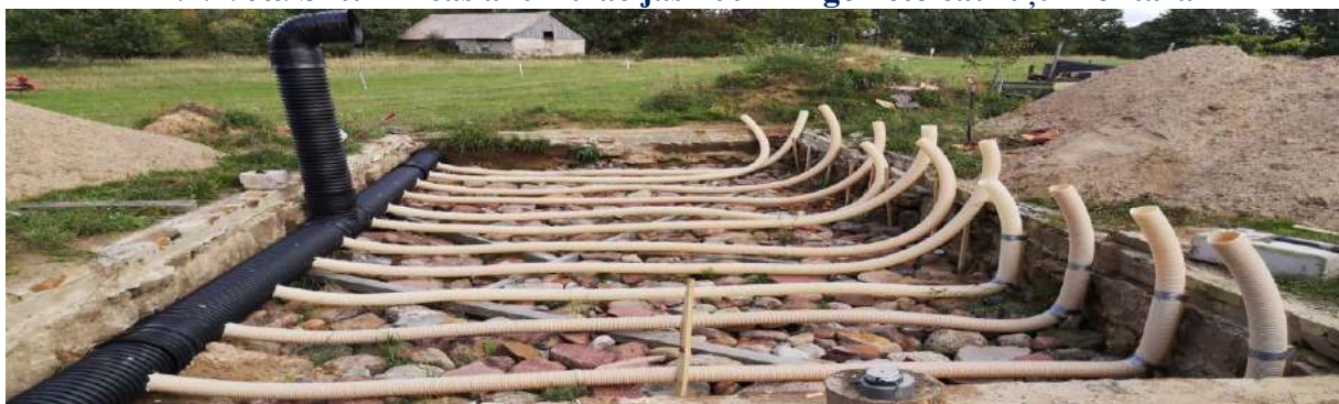
7.2.5. att. Siltumnīcas akumulācijas 100 mm gofrēto cauruļu izvietojums
