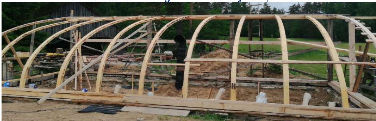
7.2.7. att. Siltumnīcas karkasa montāža
