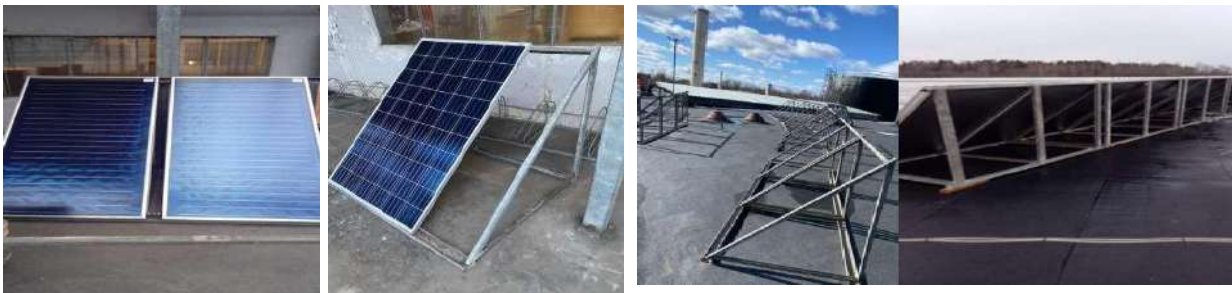
7.9. att. Saules kolektoru un saules paneļu (PV) montāža un uzstādīšana
