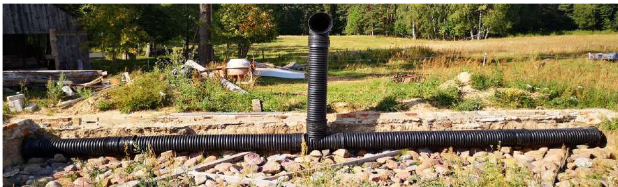
7.2.3. att. Siltumnīcas akumulācijas 300 mm gofrēto cauruļu montāža
