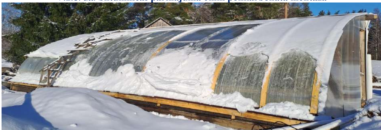
7.2.9. att. Siltumnīcas konstruktīvā risinājuma slodzes izturības monitorings 2022/23. g. ziemā
