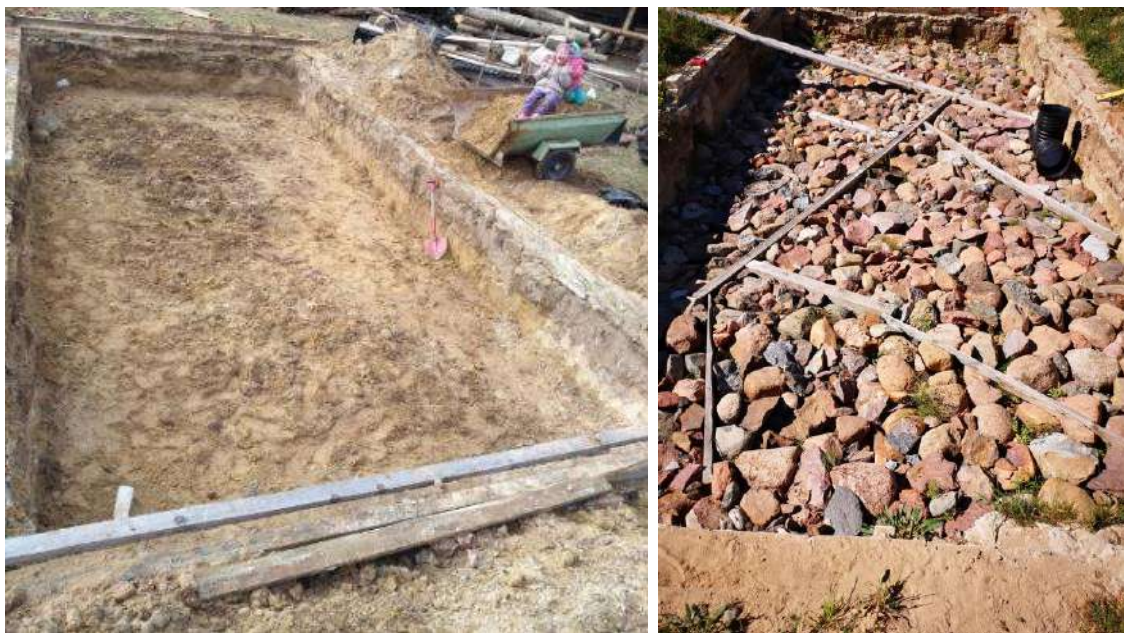
7.2.2. att. Sagatavošanas darbi akumulācijas slāņa izveidei (uz 28.02.2020)
