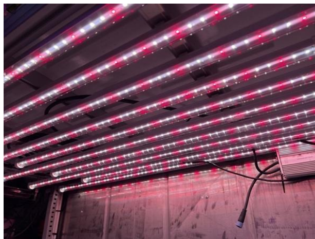
4.4.1. att. Uztādītie jaunā tipa 4DBios ražotāja gaismekļi "Broccoli" konteineri
